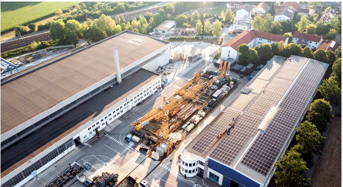
Eigenstromversorgung Fa. Hönninger - Photovoltaik auf Verwaltungs- und Werkstattgebäude
