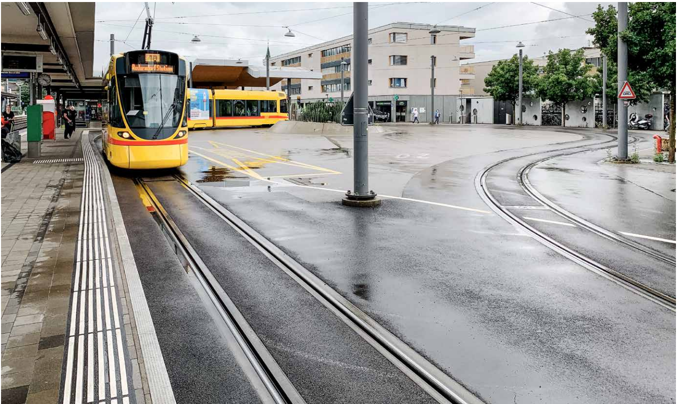
Fa. Edilon sedra – System Gleis-/Straßenaufbau
